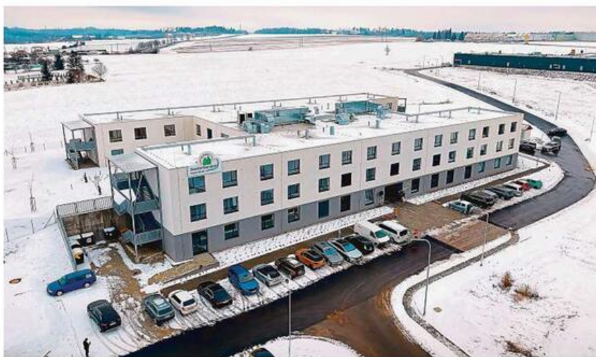
Dokončeno Výstavba domova trvala přibližně jen čtrnáct měsíců. Budova byla navržena s důrazem na energetickou úspornost a pohodlí. Využívá vytápění z bioplynové stanice. 3x foto: ESG SeniorCARE
